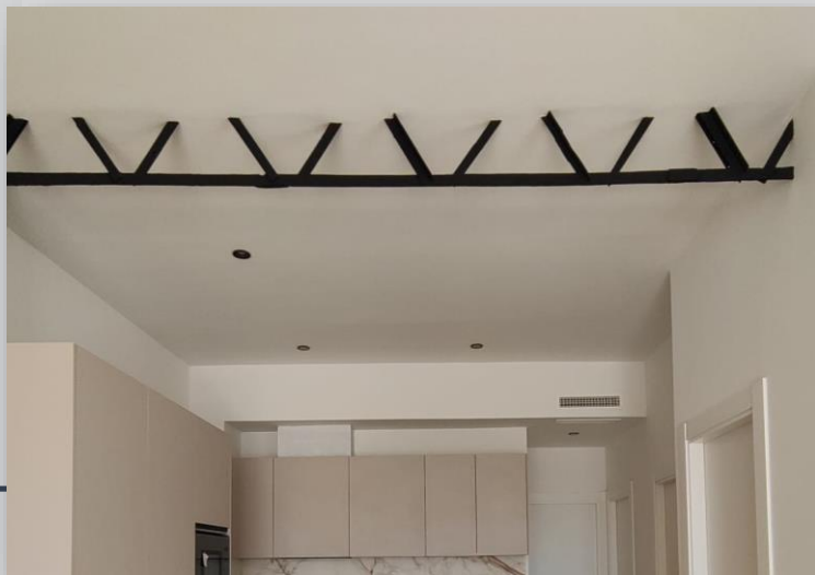
Vigas de hierro restauradas
